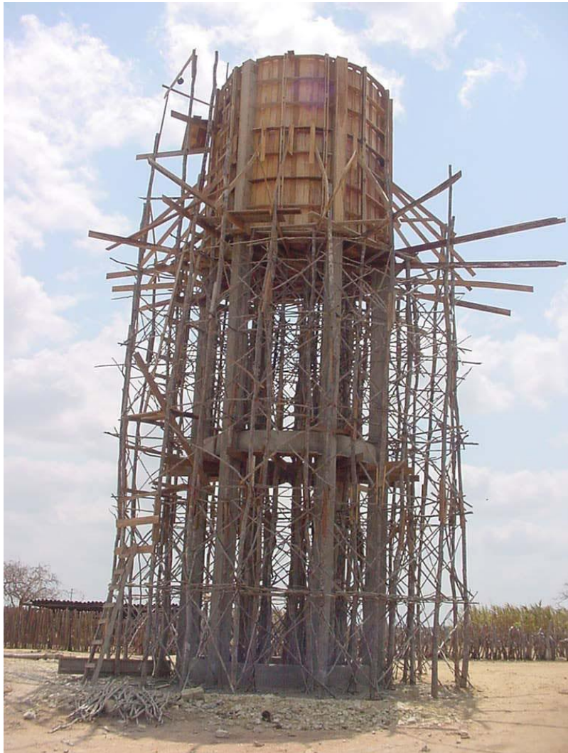
Construção do Sistema de Abastecimento de Água no Assentamento BoaVista/Lajes-RN.
