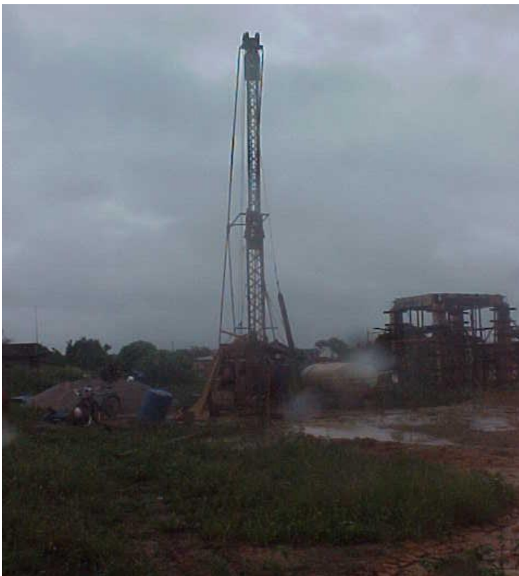
Obra de Engenharia em Aracruz (Poço Profundo – Aldeias Pau Brasil) - ES
