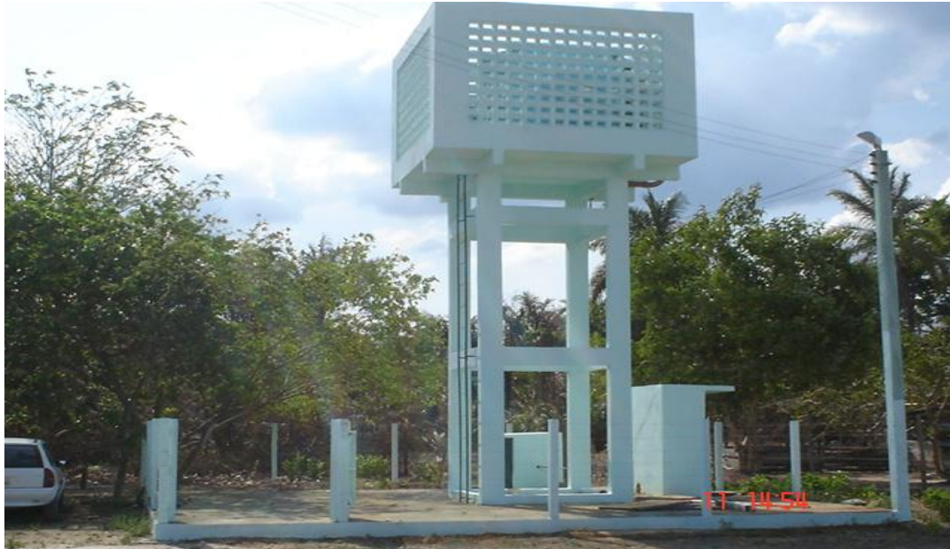
Implantação do Sistema de Abastecimento de Água na Localidade de Ilha Redonda no Município de Macapá/AP
