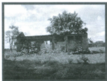
Imagem 5 - POSTO MUNICIPAL DE SAÚDE I NITEROI - Vista geral da edificação totalmente deteriorada e abandonada há bastante tempo, sob a responsabilidade da FUNASA no município de São Paulo de Olivença-AM.
