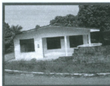
Imagem 4 - RESIDÊNCIA PARA TÉCNICOS I SEDE DO MUNICÍPIO - Detalhes para fachada e muro, sem revestimento, parcialmente destruído e sem portão no vão de acesso ao terreno. Imóvel ocupado pelo DSEI/SESAI-MS (casa de apoio indígena), sob a responsabilidade da FUNASA no município de São Paulo de Olivença-AM.
