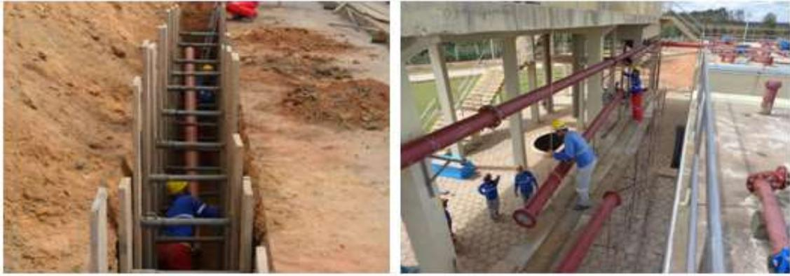
Figura 14: Fotografias retiradas de relatórios mensais de acompanhamento da obra do sistema de esgotamento sanitário do município de Taiobeiras. À esquerda consta foto de rede de esgoto executada com o necessário escoramento e à direita execução de tubulações em ferro fundido na estação de tratamento de esgotos.
