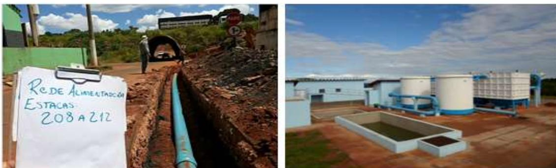
Figura 13: Fotografias retiradas de relatórios diários de acompanhamento da obra do sistema de abastecimento de água do município de Monte Alegre de Minas. À esquerda consta foto do assentamento dos tubos da adutora de água bruta e à direita vista geral da estação de tratamento de água.
