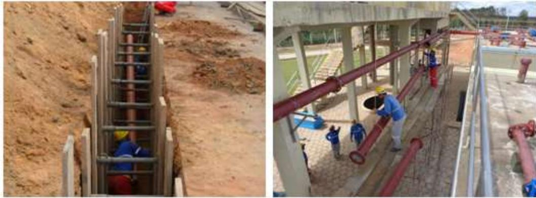
Figura 10: Fotografias retiradas de relatórios mensais de acompanhamento da obra do sistema de esgotamento sanitário do município de Taiobeiras. À esquerda consta foto de rede de esgoto executada com o necessário escoramento e à direita execução de tubulações em ferro fundido na estação de tratamento de esgotos.
