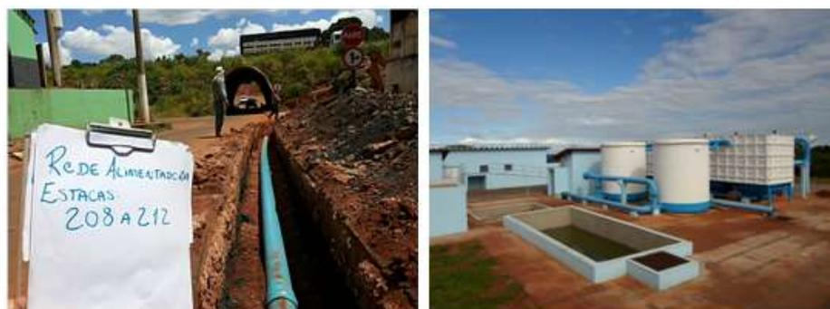
Figura 9: Fotografias retiradas de relatórios diários de acompanhamento da obra do sistema de abastecimento de água do município de Monte Alegre de Minas. À esquerda consta foto do assentamento dos tubos da adutora de água bruta e à direita vista geral da estação de tratamento de água.
