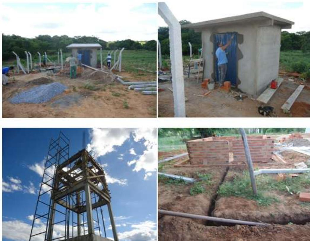
Figura 1: Construção do Sistema Simplificado de Abastecimento de Água da comunidade de Pedra Preta, município de Manga/MG.
