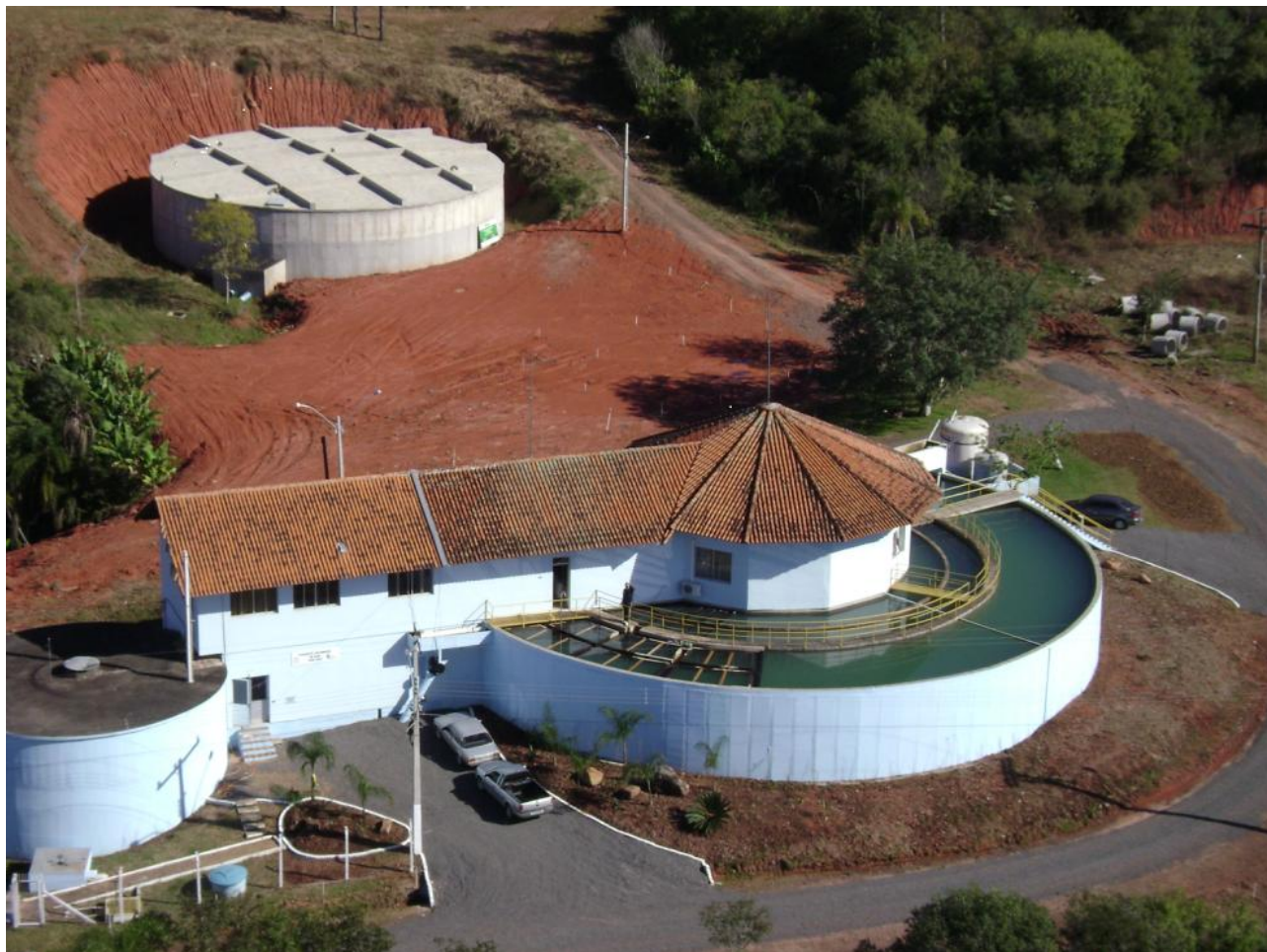
Obra de Sistema de Abastecimento no município de Vera Cruz Foto: Suest/RS
