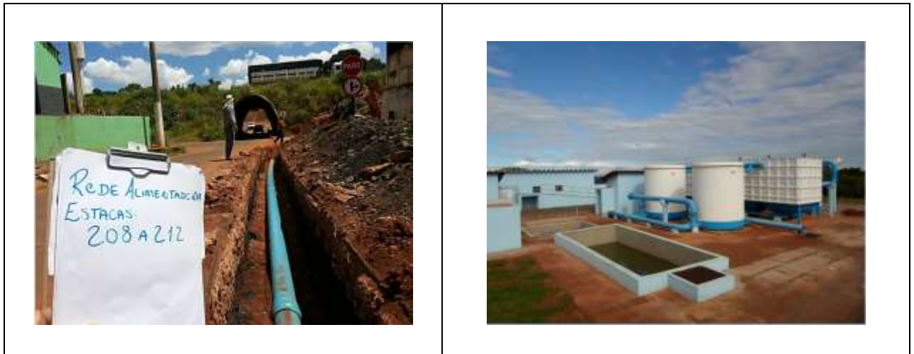
Figura 1: Fotografias retiradas de relatórios diários de acompanhamento da obra do sistema de abastecimento de água do município de Monte Alegre de Minas. À esquerda consta foto do assentamento dos tubos da adutora de água bruta e à direita vista geral da estação de tratamento de água.
