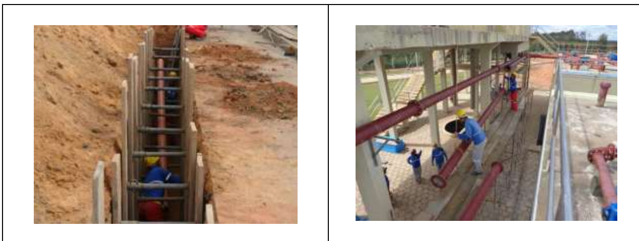
Figura 3: Fotografias retiradas de relatórios mensais de acompanhamento da obra do sistema de esgotamento sanitário do município de Taiobeiras. À esquerda consta foto de rede de esgoto executada com o necessário escoramento e à direita execução de tubulações em ferro fundido na estação de tratamento de esgotos.
