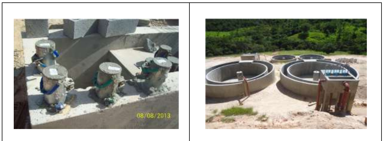
Figura 2: Fotografias retiradas de relatórios diários de acompanhamento da obra do sistema de esgotamento sanitário do município de Alpinópolis. À esquerda consta foto de coleta de corpo de prova de concretagem (controle tecnológico da execução do concreto) e à direita vista da estação de tratamento de esgoto.
