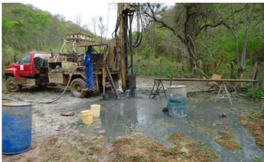
Figura 2: Construção do poço tubular da comunidade de Gravatá, Município de Chapada do Norte/ MG.
