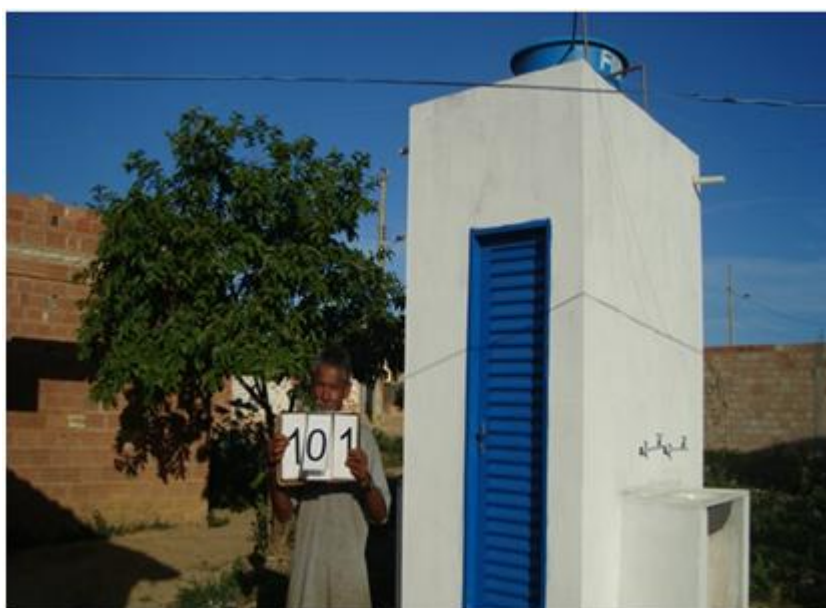
Figura 4: Exemplo de Módulo Sanitário Domiciliar implementado no município de Águas Vermelhas.
