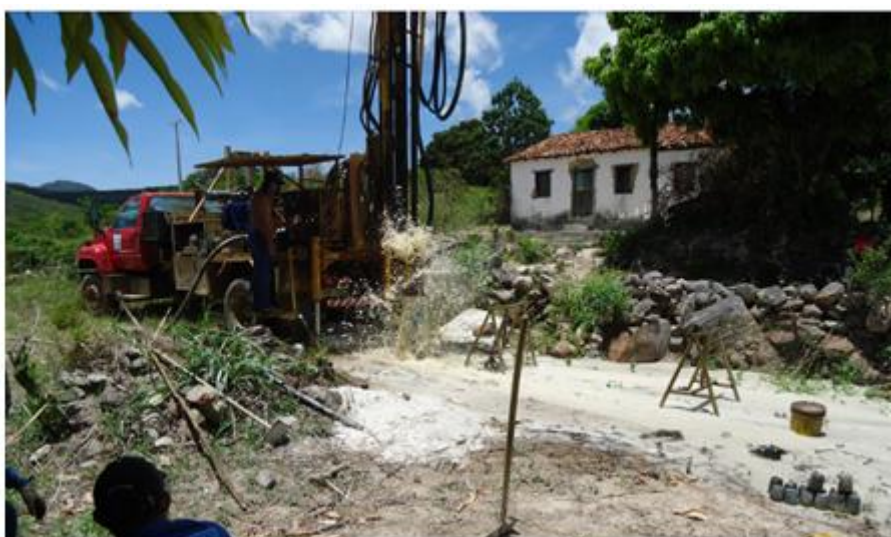
Figura 1: Construção do poço tubular da comunidade de Várzea da Manga, Município de Matias Cardoso/ MG.
