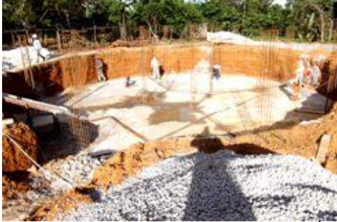
Visita a obra do Sistema de Abastecimento de Água da sede do município de Oiapoque
