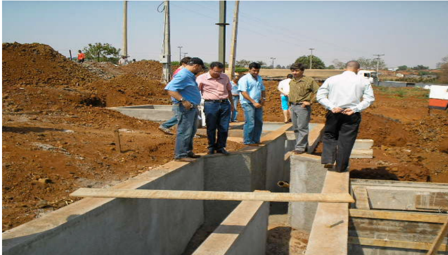
Construção do Sistema de Esgotamento Sanitário no município de Montividiu/GO (conv. exercícios anteriores - meta 2)
