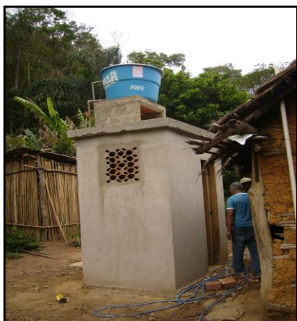
Melhorias Sanitárias Domiciliares
