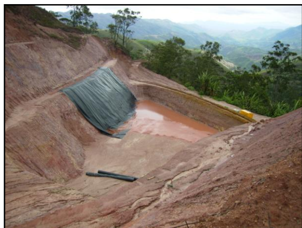
Implantação de aterro sanitário
