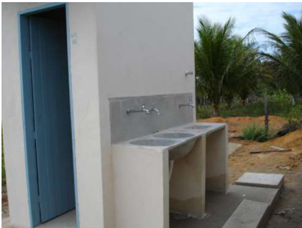
Foto de obra de Melhoria sanitária domiciliar
