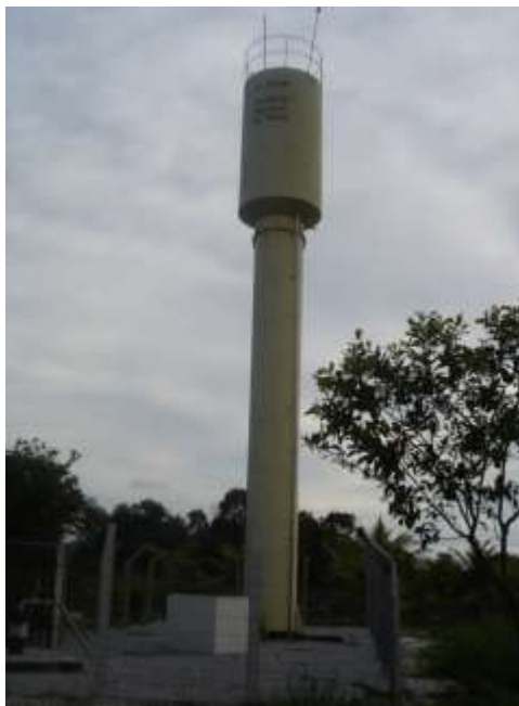
Foto do reservatório de água
