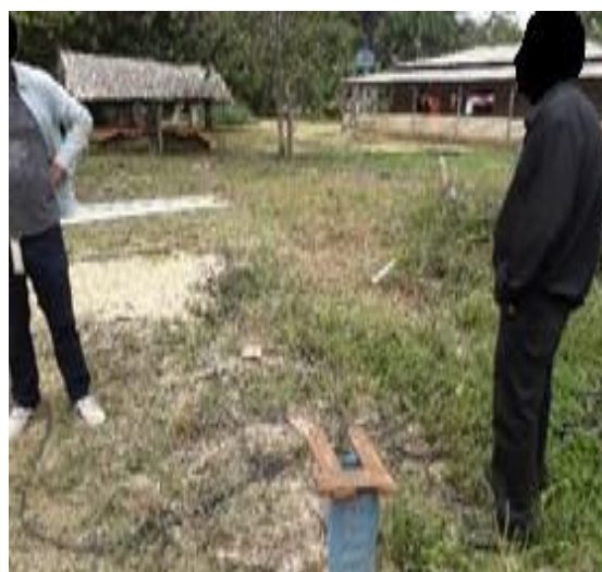
Figura 6: Município de Belterra / Comunidade Cinquenta e Sete – Poço profundo tubular aberto
