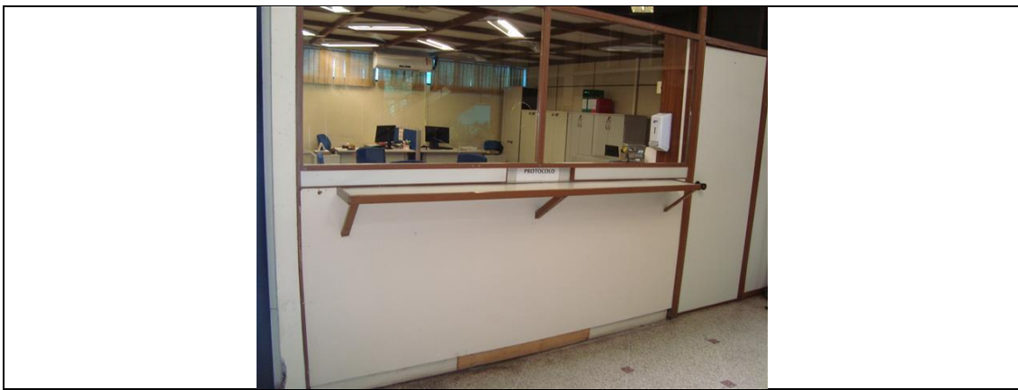
Balcão de atendimento – não possui dimensões adequadas.
