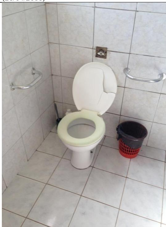
Foto 6: Sanitário para deficiente fora das especificações e em mau estado de conservação. (26/04/2016)
