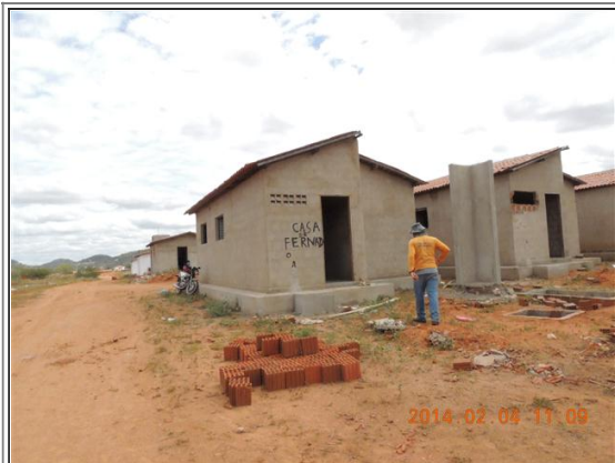
Foto 1 - Unidades Habitacionais - Obra Incabada - 04/02/14
