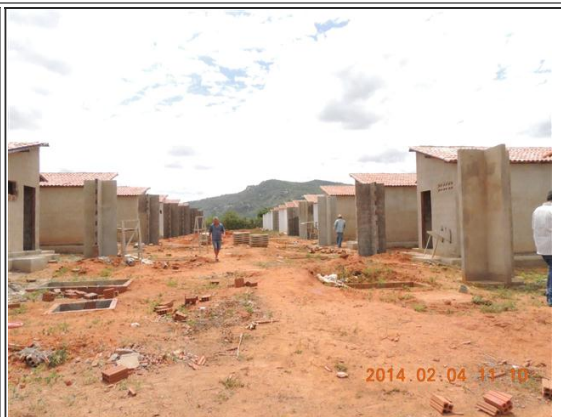
Foto 2 - Unidades Habitacionais - Obra Incabada - 04/02/14
