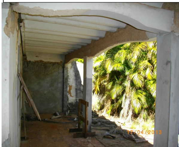
Varanda da frente da casa, com algumas paredes sem reboco e a parede ao fundo chapiscada (serviço iniciado por meio do contrato nº 22/2010)
