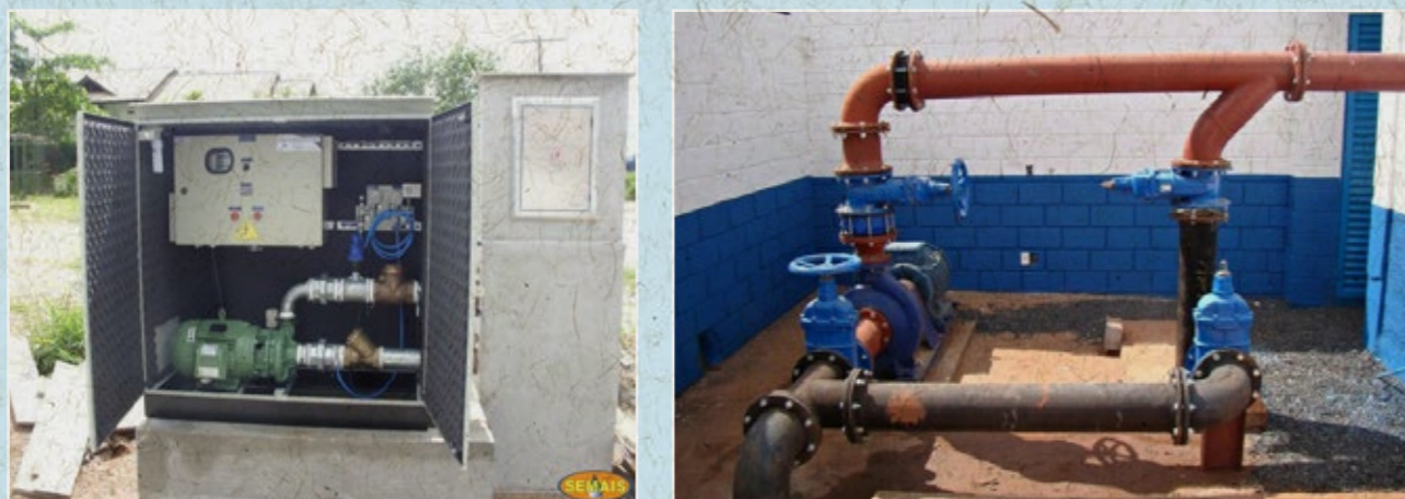
Figura 5 – Estações Elevatórias (típica e pressurizada)
