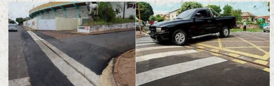
Figura 10 Sarjetão instalado no cruzamento de via pública
