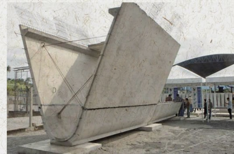
Figura 12 Galeria de macrodrenagem
