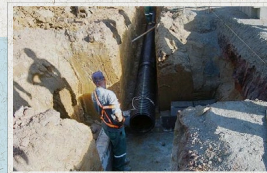
Figura 7 Detalhe de galeria em construção
