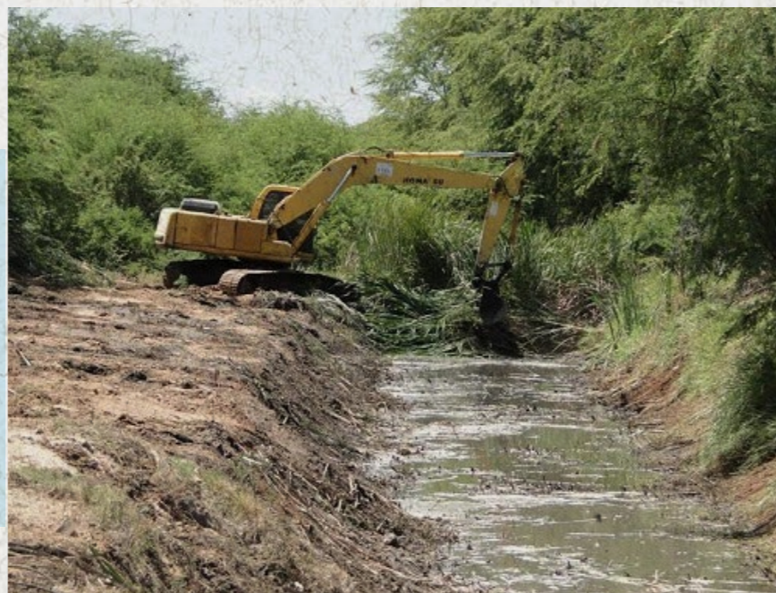
Figura 14 Obras para ampliação e retificação de canal natural
