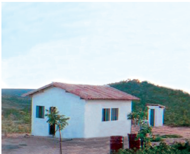
Figura 4. Casa depois da reconstrução
