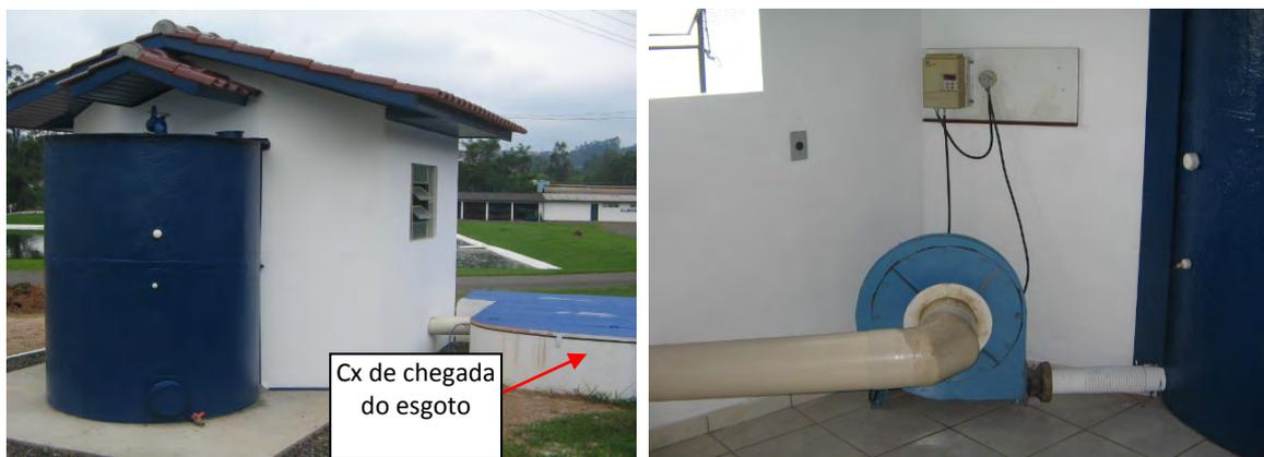
**Figura 4** - Sistema de transporte dos gases da caixa de chegada do esgoto na ETE até o biofiltro.
