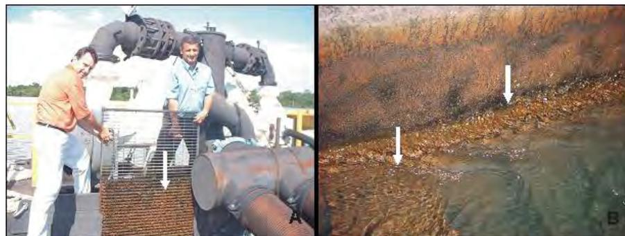
**Figura 1-2** - Estruturas da estação ETA Vila C. A) Grifo do flutuante de captação de água com a metade submersa; B) obliterada (seta) pelo crescimento descontrolado de *L. fortunei*.
