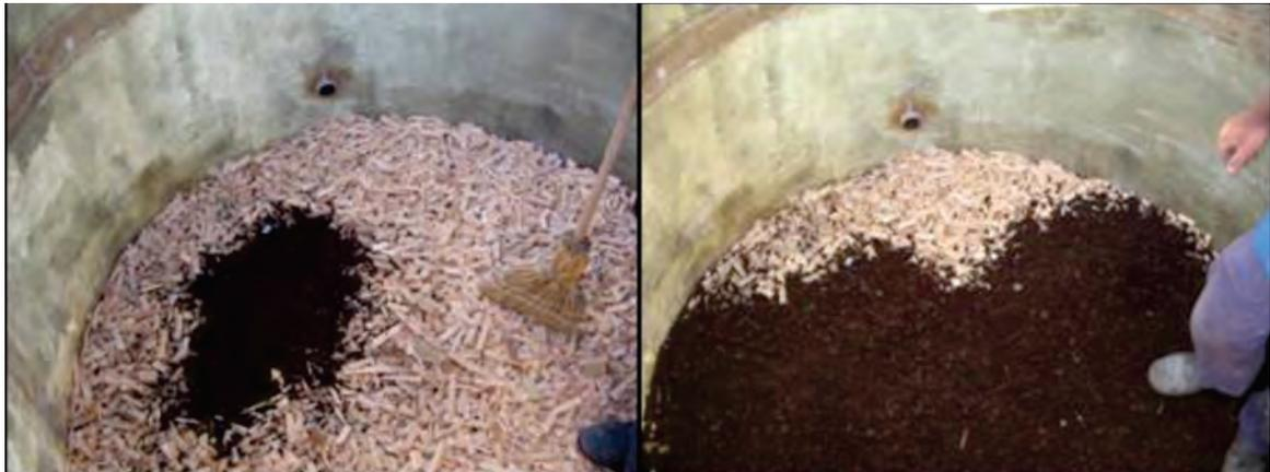
**Figura 5** - Interior do biofiltro preenchido com cavaco de madeira e turfa.
