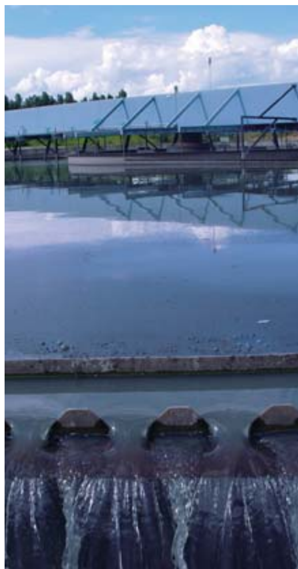
Estação de Tratamento de Esgoto
